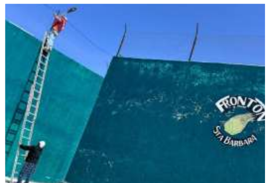
Apoyo al frontón para reparación de luminarias.
