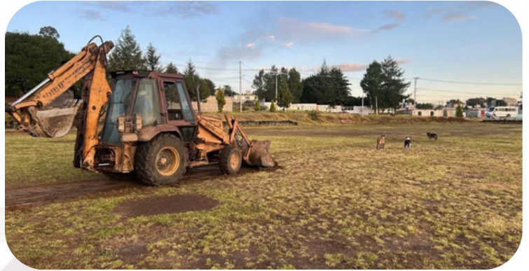
Gestión de maquinaria para limpieza del campo deportivo de futbol por inicio liga en la comunidad de Santa Clara.
