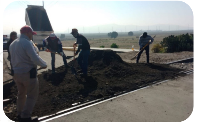
Gestión en conjunto con Dirección de obras públicas para el material de frezado, para arreglar el paso de la vía de Santa Clara.
