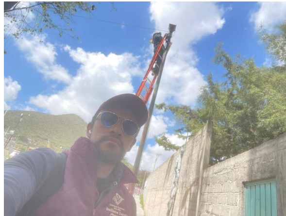
Servicios municipales cambiando luminaria de comunidad 1/10/25
