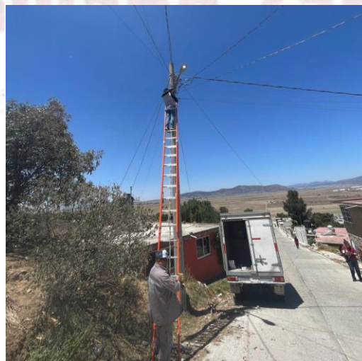
Servicios municipales cambiando luminaria de comunidad
